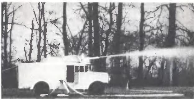
**ВОДА ВМЕСТО ОГНЯ.** Румынский пожарный автонасос «Бучедж» очень похож на броневик, его башня вращается вкруговую, а ствол возвышается до 80° и склоняется до —15°. Кроме водяной струи дальностью 40 м, «Бучедж» «стреляет» воздушной пеной. Шины автомобиля защищены водяной завесой, поэтому он проходит даже по горящим участкам.
